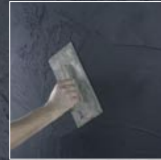
2. Die Oberfläche wird mit einer alten Glättkelle strukturiert.
