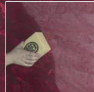
6. Im Anschluss wird das PANDOMO-Steinöl dünn aufgetragen und überschüssiges Öl mit einem fusselfreien Lappen abgerieben.
