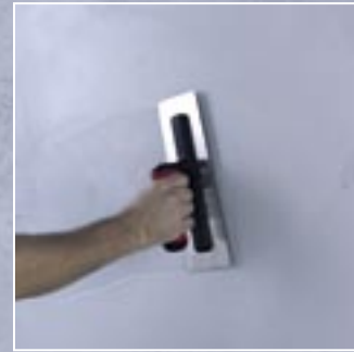
4. Anschließend mit einer venezianischen Glättkelle abstucken.
