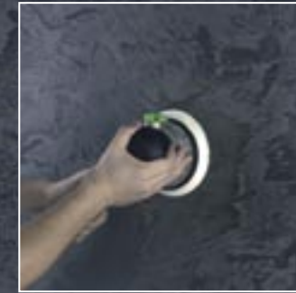
4. Anschließend wird die Oberfläche mit einem Exzenter-schleifer und 120er Schleifpapier poliert.
