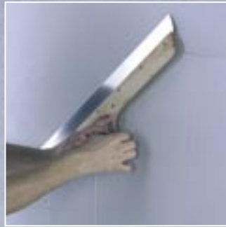
2. Die Oberfläche wird mit einem Flächen-Rakel abgeglättet und strukturiert.
