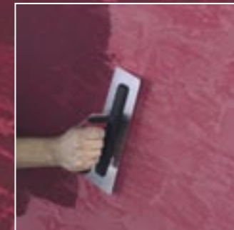
4. Der zweite Farbton wird mit der venezianischen Glättkelle dünn auf die Oberfläche aufgekratzt.
